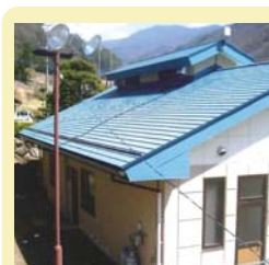
公民館の備品設置や公園遊具の修繕
