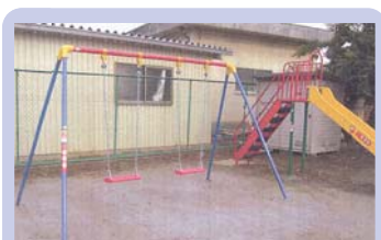
地域の公園のぶらんこすべり台の修繕
